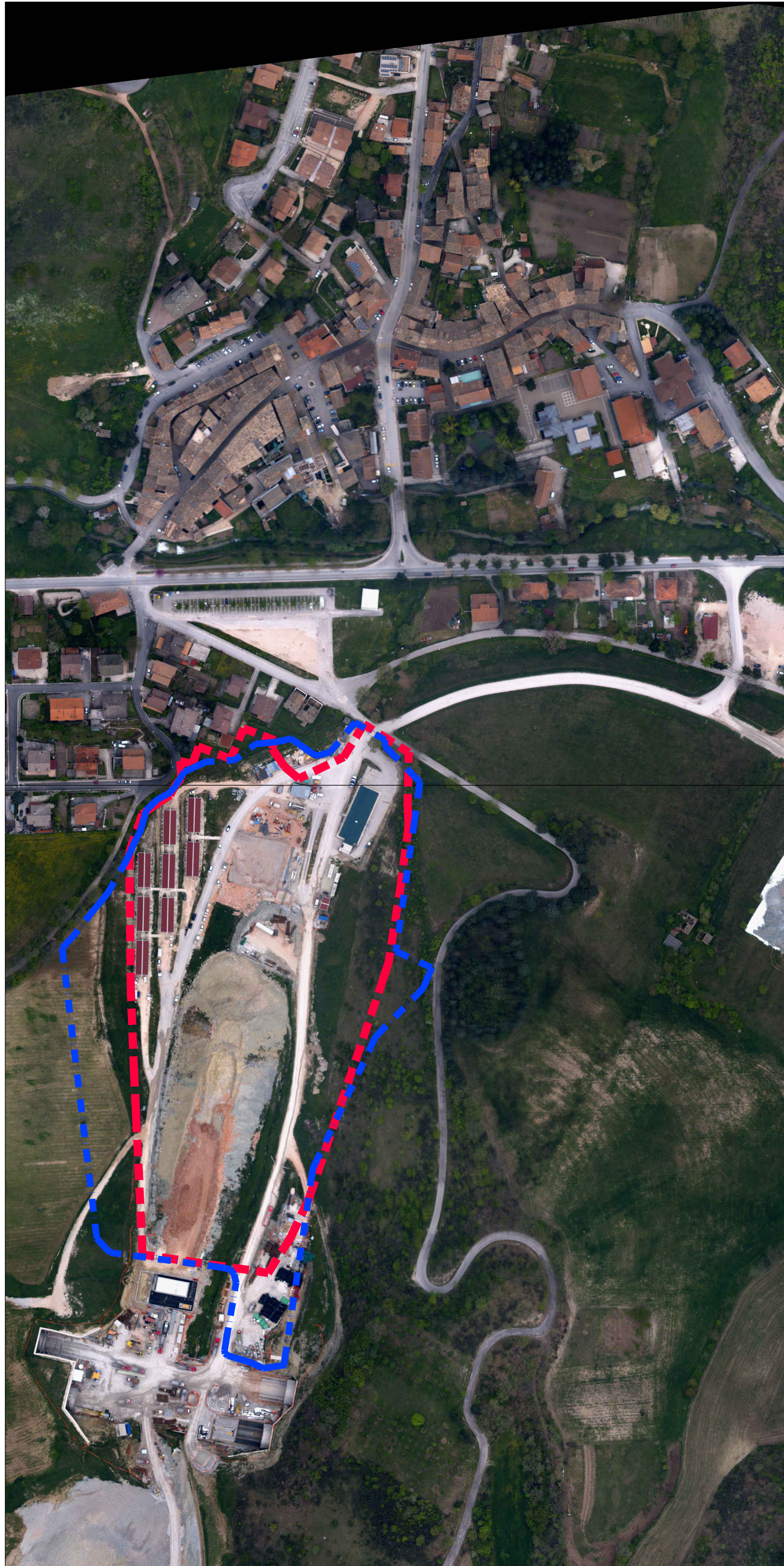
FOTO AEREA STATO ATTUALE
