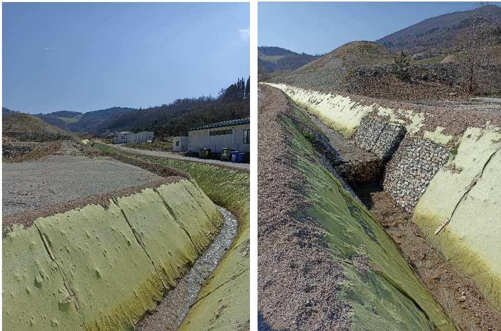
Figura 22 Sezione nel tratto di fosso DEVIATO con pendenza 2,00%
